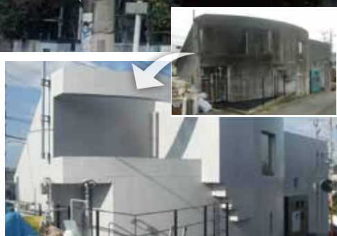
外壁塗装工事 (30～40坪)
