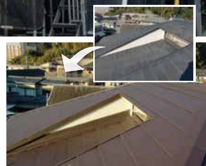
外壁・屋根工事 (30～40坪)
